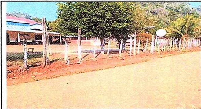
Foto 3: Mantenimiento de muro perimetral por deterioro
