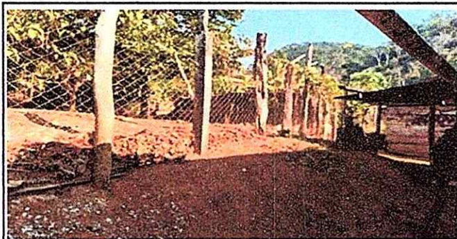
Foto 5: mantenimiento por deterioro de postes
